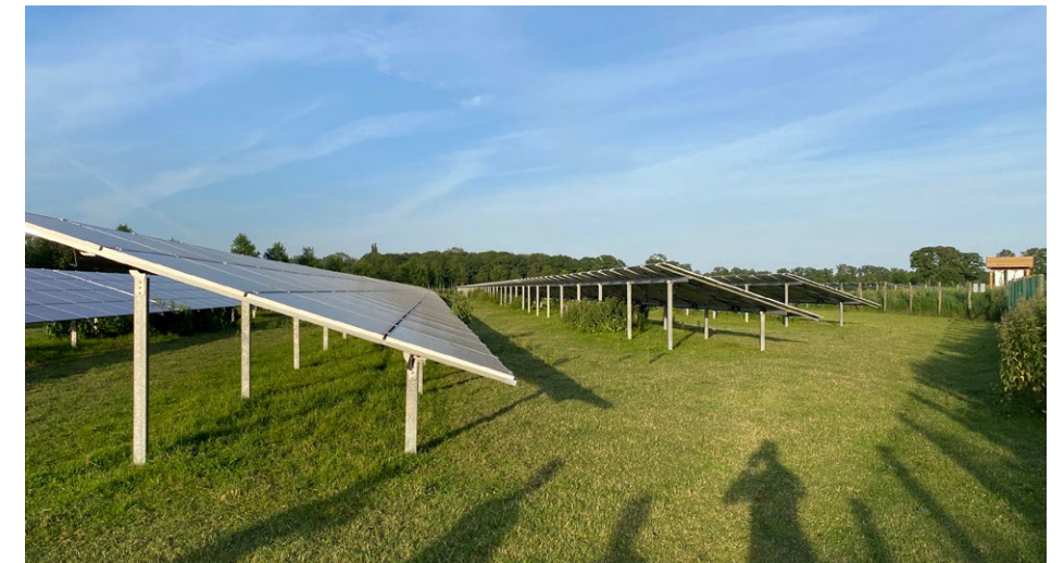
Goed geëgaliseerde grond (bron: Eelerwoude)
