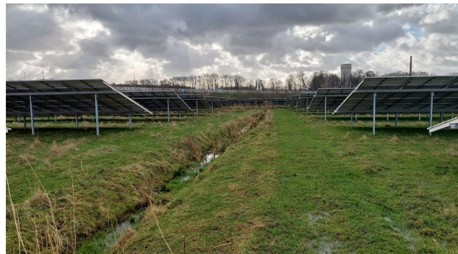
Geschikte onderconstructie voor lange lijnen voor robotmaaier (bron: Eelerwoude)
